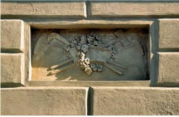
mento delle murature esterne dell'edificio, particolarmente colpite dall'attività erosiva degli agenti atmosferici: Vitruvio Calce Romana, una calce idraulica naturale a presa lenta ed elevata elasticità, e Vitruvio Stabical, un rasante minerale anticavillante, entrambi prodotti che si rifanno alla tradizione lombarda e hanno il vantaggio di essere biocompatibili per l'assoluta naturalità dei loro componenti.
