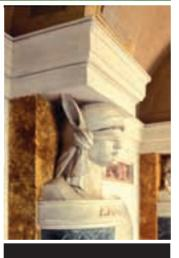
Si è proceduto all'eliminazione delle manomissioni e degli interventi realizzati in epoca recente e alla ricostruzione, attraverso inserti ben riconoscibili per colore e materiali, delle parti mancanti
