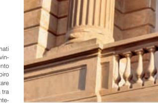
La pulizia e il consolidamento delle parti originarie hanno rappresentato il primo obiettivo da raggiungere, seguito poi dall'eliminazione delle manomissioni e degli interventi realizzati in epoca recente, e infine dalla ricostruzione, attraverso inserti ben riconoscibili per colore e materiali, di parti mancanti.
